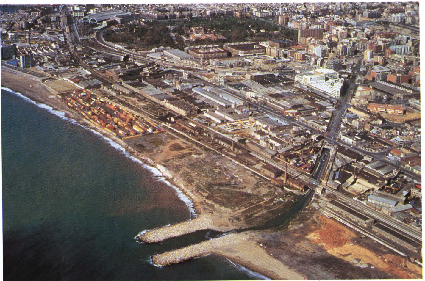
Estado actual del Parque del Mar.
