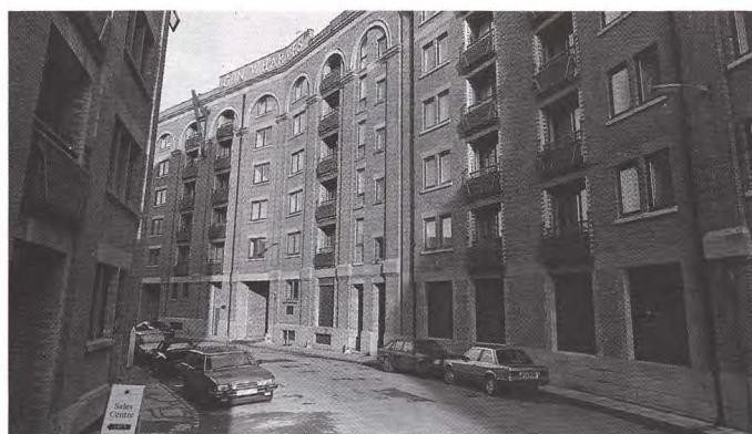
Rehabilitación de los almacenes Gun Wharves, Wapping.
